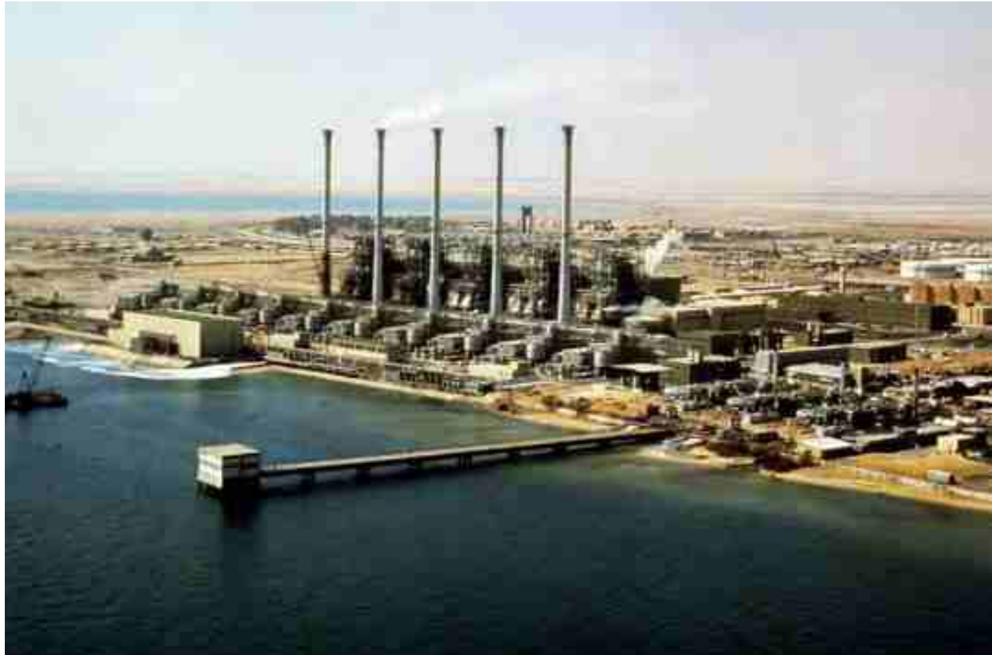
사우디아라비아 알코바 담수설비 전경
