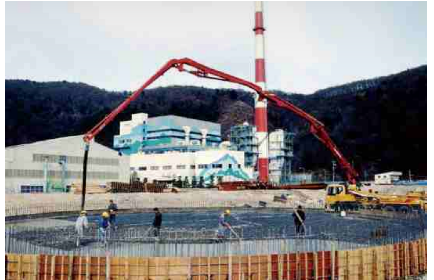
1997. 03 현대정유 저유소 공사
