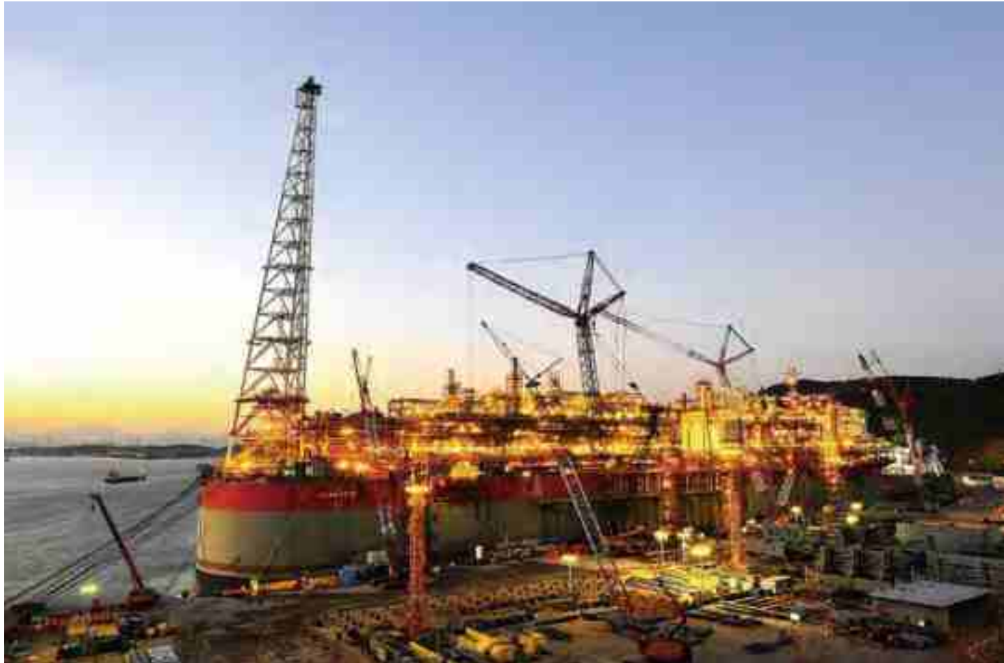
건조 중인 우산 FPSO 전경
