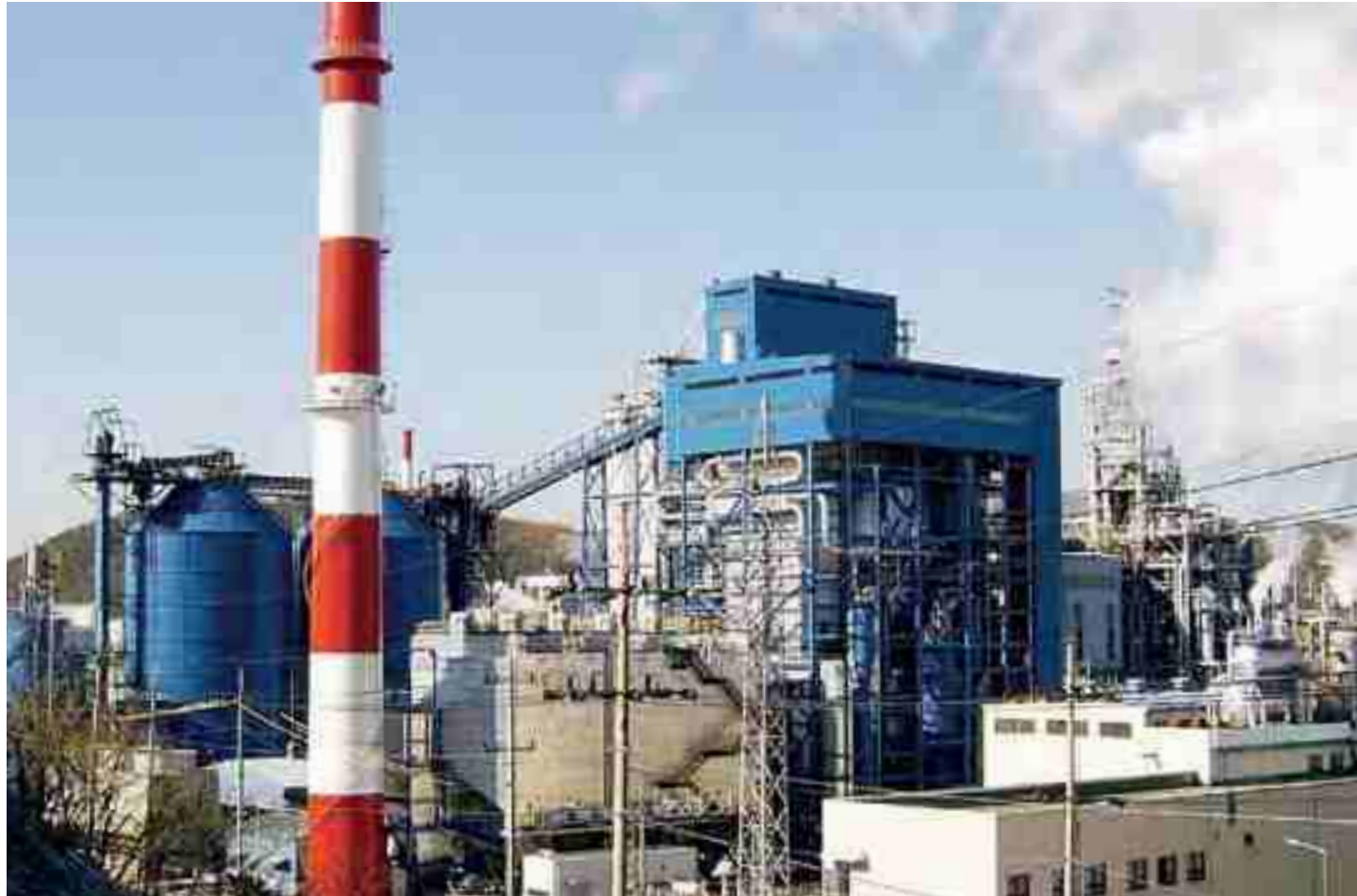
2003. 12 금호석유화학 열병합발전소 보일러공사 준공
