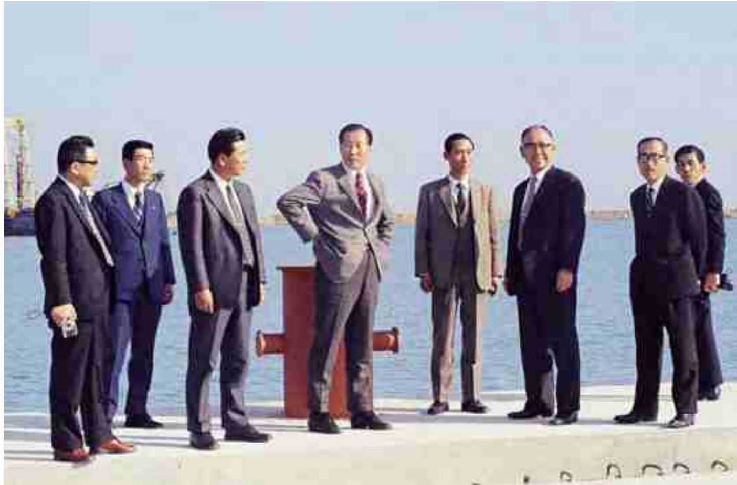
1972 울산조선소 건설현장을 찾은 일본 가와사키중공업 이사진과 정주영 창업자
