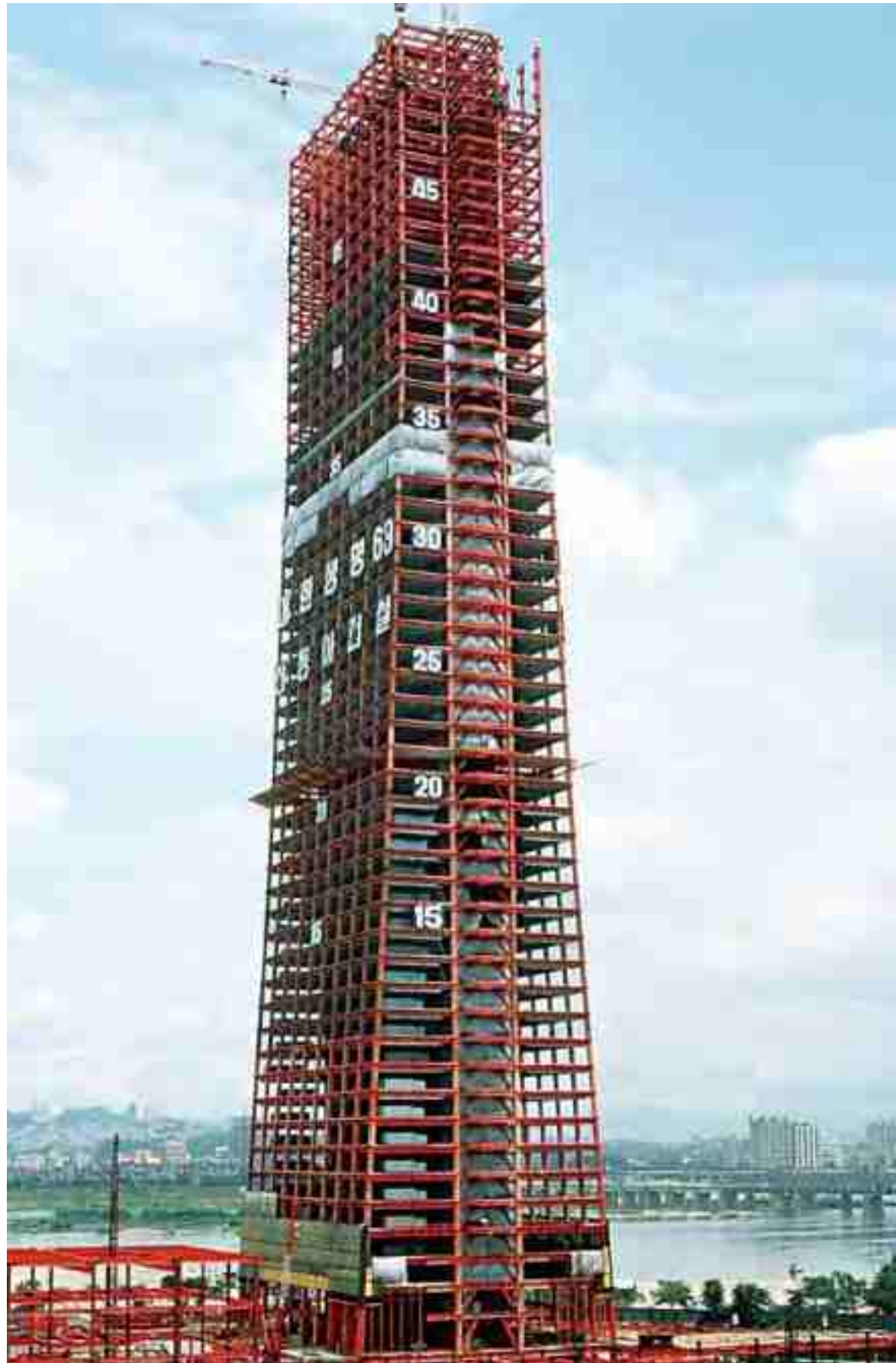
현대중공업이 철골구조물을 납품한 63빌딩(현 한화생명) 건축공사
