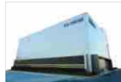
2017.11 현대중공업 51.5MWh급 ESS센터 준공
