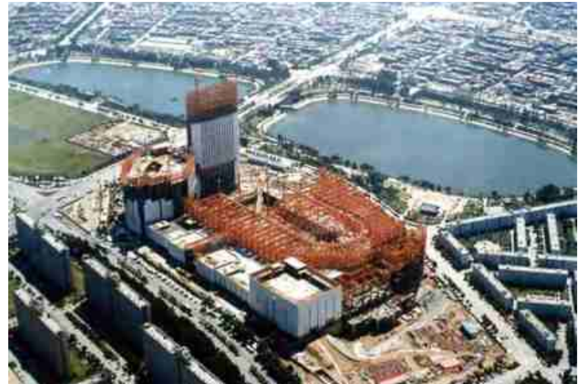
현대중공업이 철골구조물을 납품한 롯데월드 건설공사
