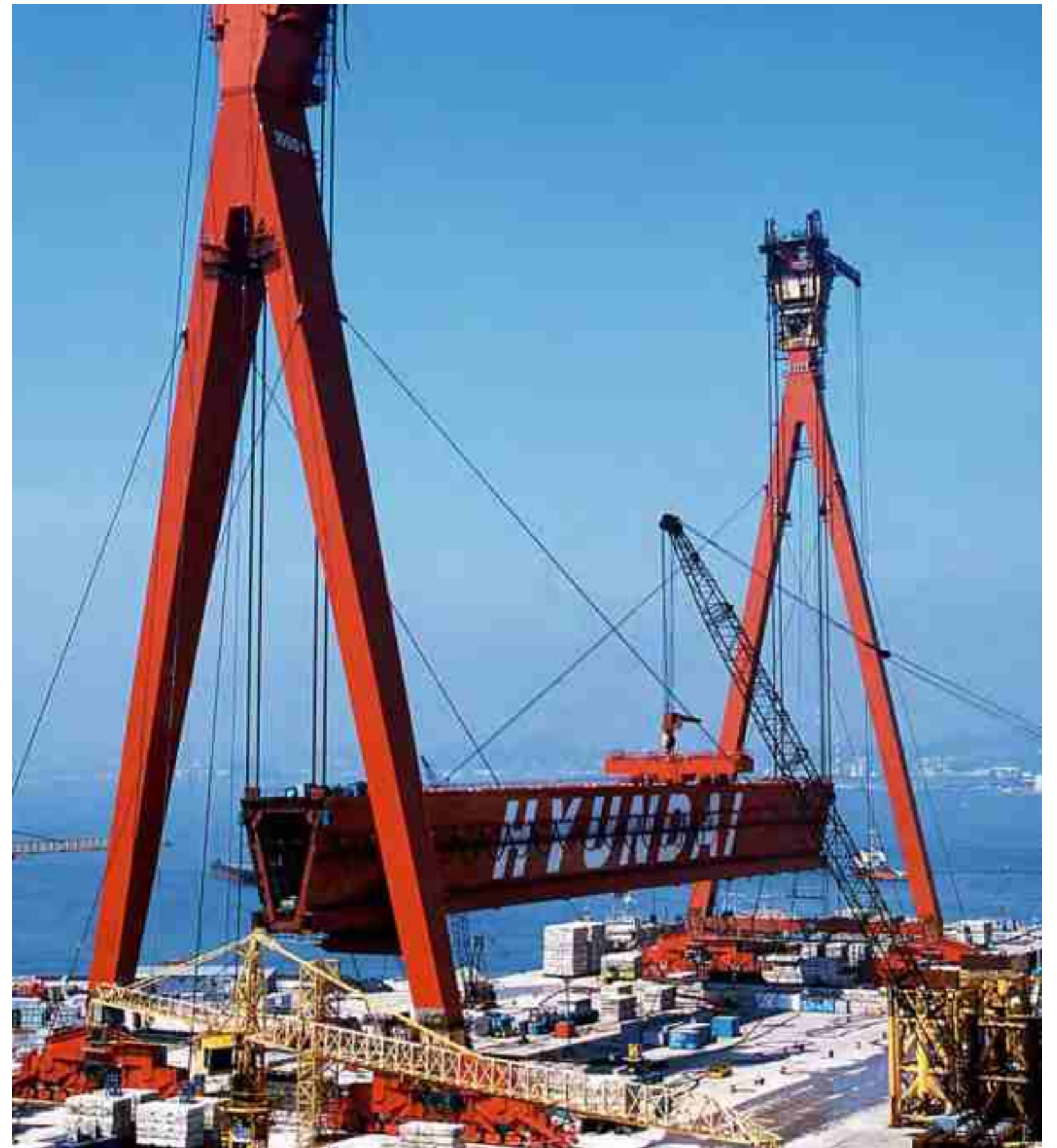
2003. 05. 27 1600톤 콜리엇 크레인 상부구조물 탑재
