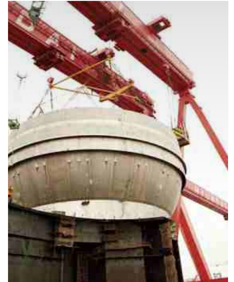
1992. 08 LNG 1호선 구형 탱크 탑재
