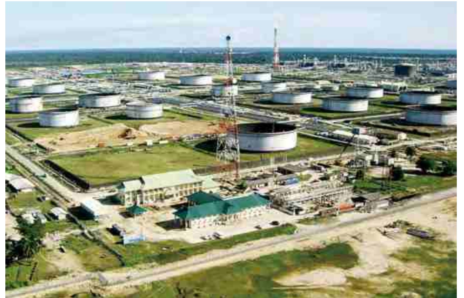
나이지리아 EGP-3(정유&가스설비) 공사 현장
