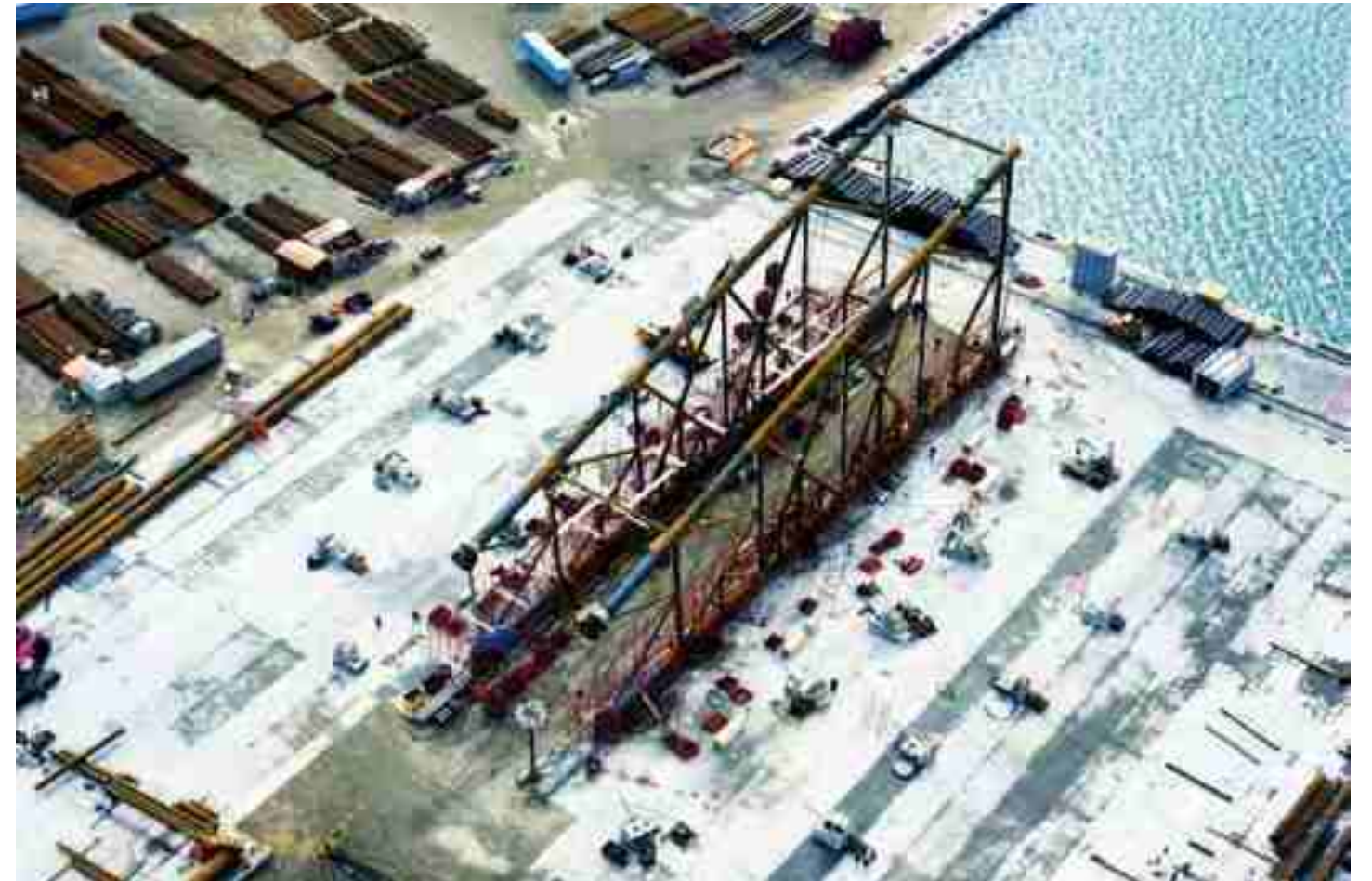
1981. 02. 24 EPMI로부터 수주한 CAP Structure 건설 전경
