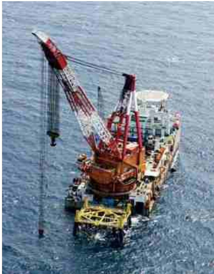
동해-1 가스전 시설 설치 작업
